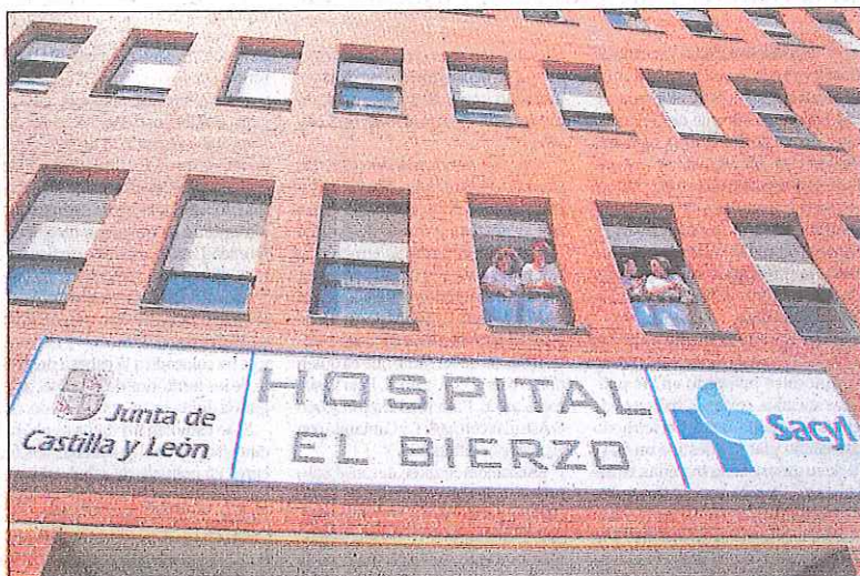
Fachada del hospital ponferradino que tiene dificultad para encontrar a oncólogos que ocupen las plazas del centro. ICAI.
